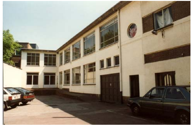
Le bâtiment arrière et la cour interne
